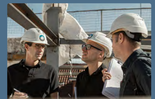
BAULEITER VOR ORT AUF DER BAUSTELLE
